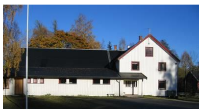
Forsamlingshus fra 1920 som fortsatt brukes som selskapslokale. Scena er oppgradert i seinere tid, og det er montert nytt teaterlys.
